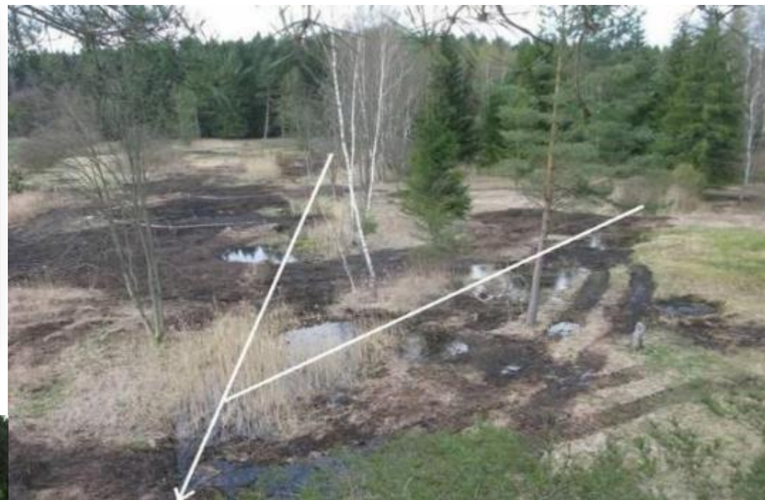
Obr. 8 Pohľad na plochu bezprostredne po dokončení revitalizácie. Šípkami je označené pôvodné vedenie odvodňovacích priekop. V rámci revitalizácie boli vytvorené kaskády malých jazierok a zavodnených depresí (foto Filip Lysák).
