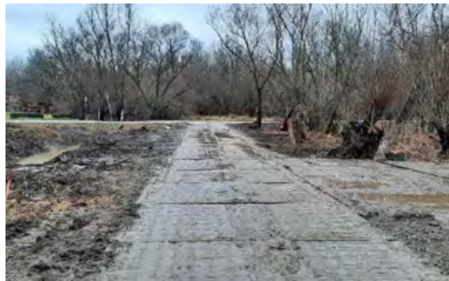
Obr. 49. Použitie oceľových panelov pre príjazd techniky (fotografia: Vilém Jurek).
