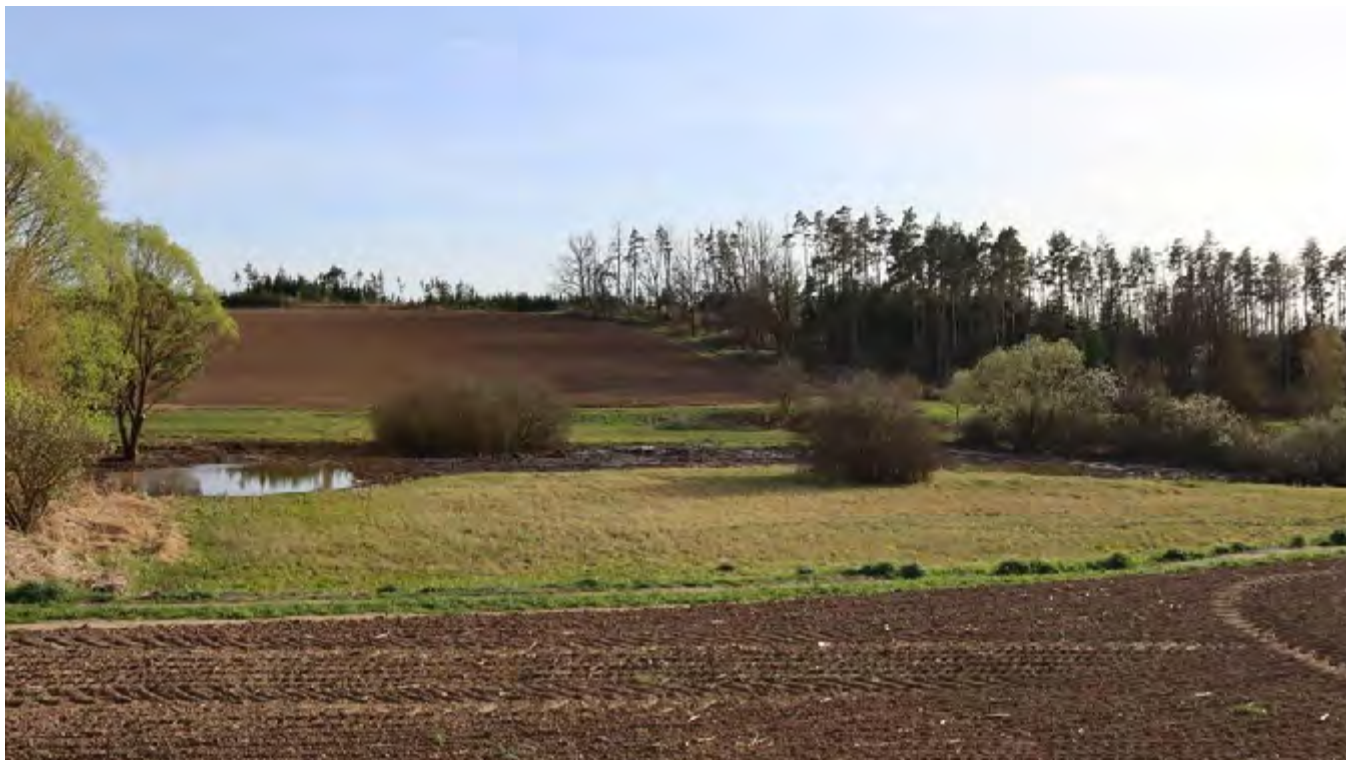
Obr. 167. Na Klátově (Myslůvka, ČR): V rámci obnovy degradovanej časti slatiny bolo nutné strhnúť mačinu na celej degradovanej ploche. Pri strhnutí vzniklo veľké množstvo materiálu. Vzhľadom na obmedzené finančné prostriedky nebolo možné nadbytočný vykopaný materiál odviezť a uložiť mimo lokality. Preto bol vykopaný materiál použitý na hradenie dvoch jazierok na hornom a dolnom okraji revitalizovanej plochy. Voda zadržaná v jazierkach zároveň pomáha stabilizovať vodný režim v období výrazného sucha v lete. Hrádze a vodné plochy boli umiestnené do miest, kde bol zároveň nízky potenciál obnovy cennej slatinnej vegetácie – plochy bez prítomnosti humolitovej vrstvy. Veľký dôraz bol kladený na prirodzené prechody hrádzok do okolitého terénu, vzniknutý reliéf pôsobí prirodzene (fotografia: Ester Ekrťová).
