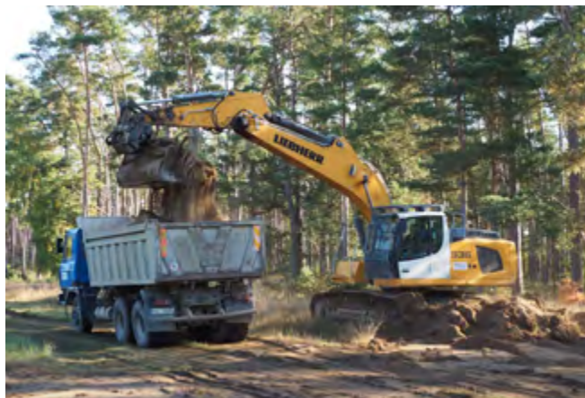
Obr. 143. Bager pri strhávaní mačiny v NPP Váté písky; strhnutá hmota je odvážaná do pieskovne (fotografia: Sylva Holánová).
